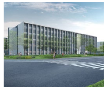
北海道薬科大学研究棟(南側)
