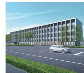
北海道薬科大学共用講義棟(南側)
