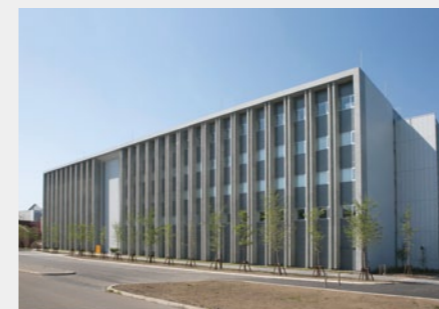
保健医療学部棟外観(北側)
